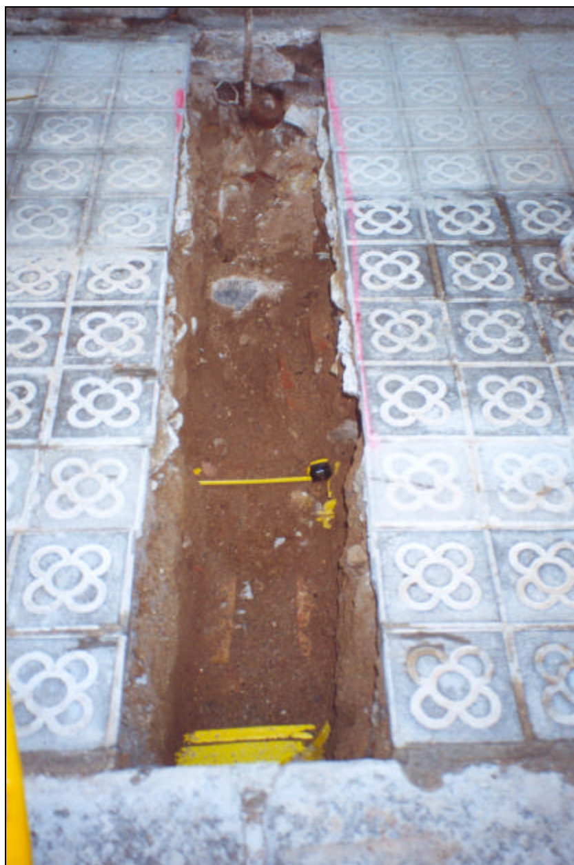
Foto 4.- Vista longitudinal de la RASA 2 amb els diferents serveis apareguts i els fonaments de l'edifici al fons.
