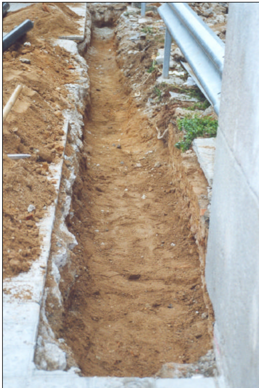
Foto 6.- Vista longitudinal de la RASA 4 amb els fonaments de l'edifici enderrocat l'any 2001 a la dreta.
