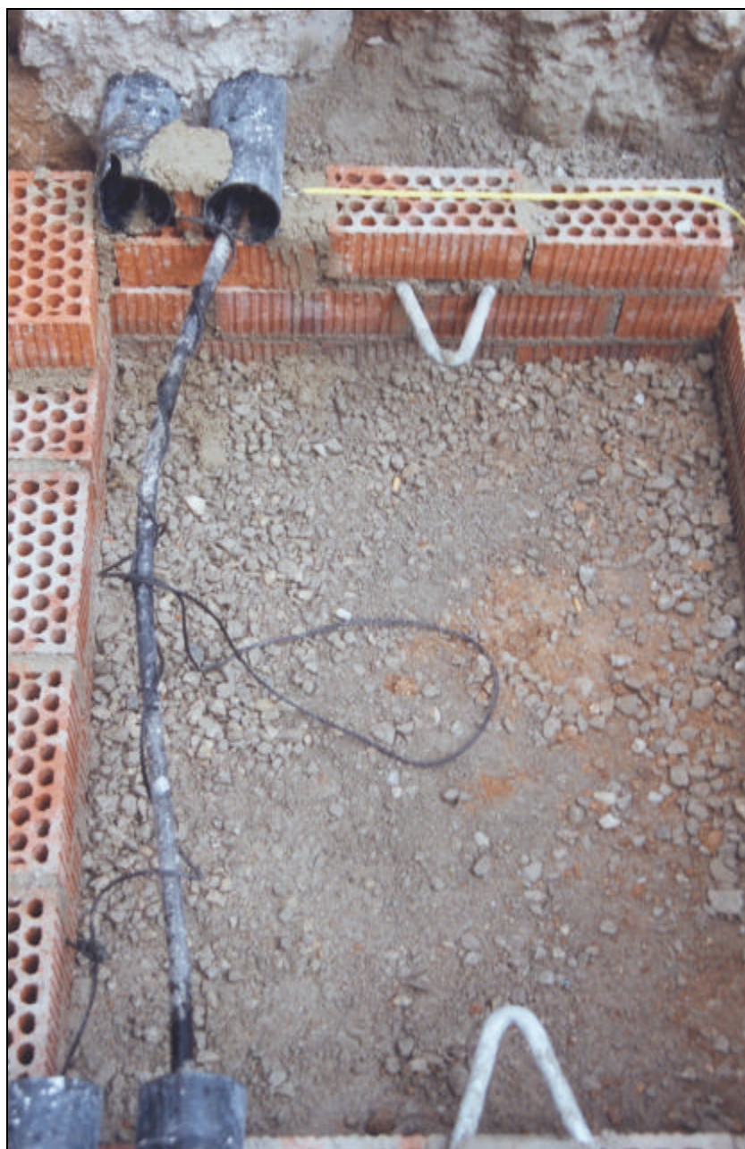
Foto 1.- Vista general de la RASA 1 amb la construcció de l'arqueta en curs.
