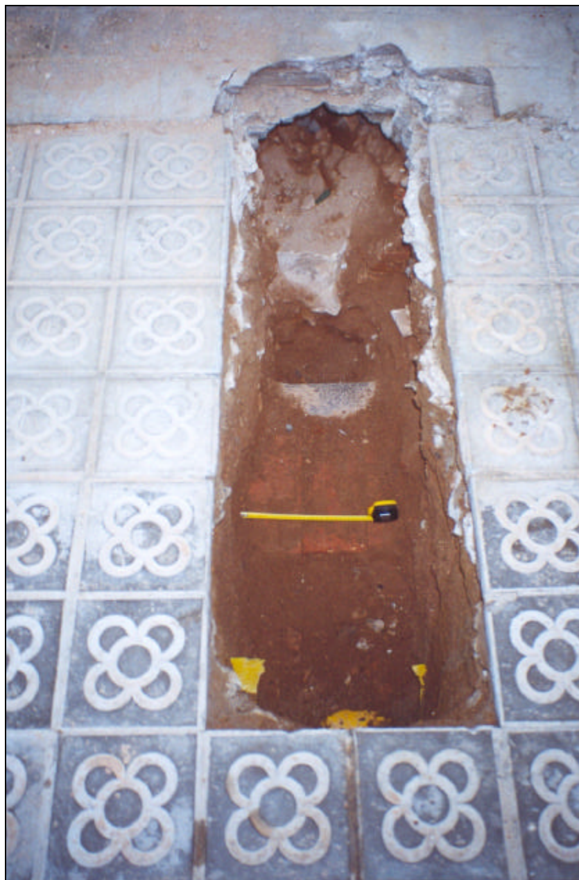
Foto 5.- Vista longitudinal de la RASA 3 amb els diferents serveis apareguts i els fonaments de l'edifici al fons.
