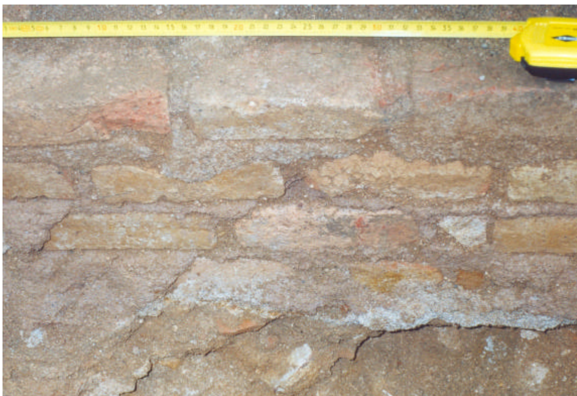
Foto 7.- Detall dels fonaments apareguts, U.E. 402, a la RASA 4 on es poden apreciar els materials constructius (maons, morter de calç blanc).
